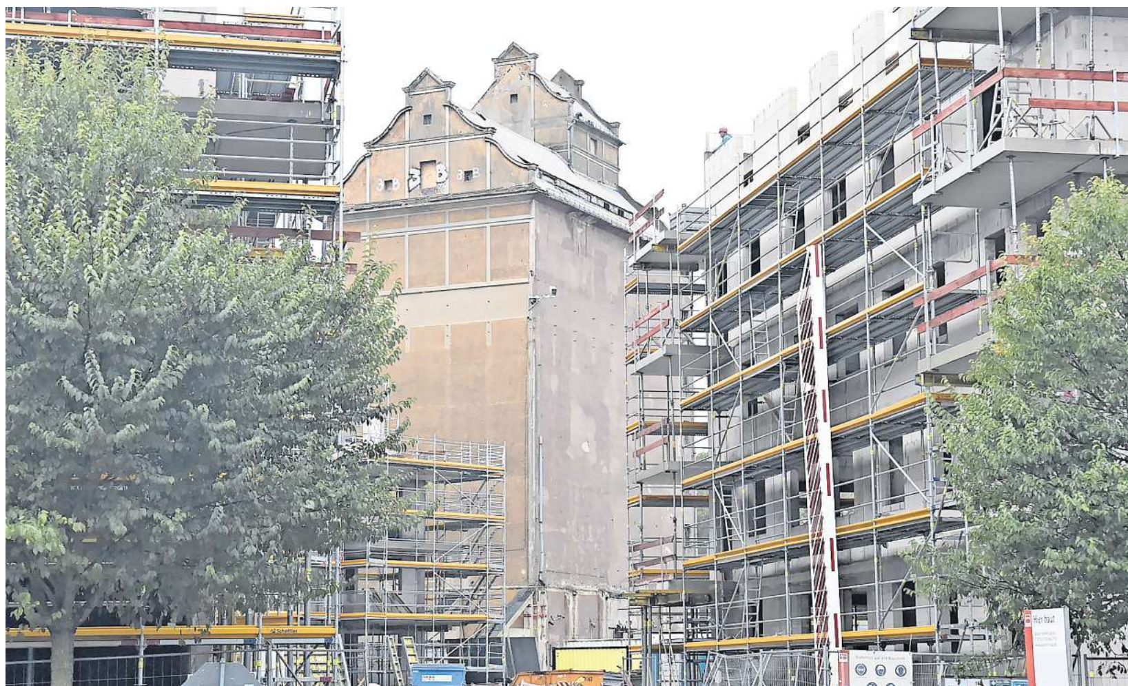
Seit Jahren wird um die Zukunft des Speichers gestritten und diskutiert – nun ist diese Frage geklärt. Es wird Wohnraum entstehen. FOTOS: ROBERT ROESKE
